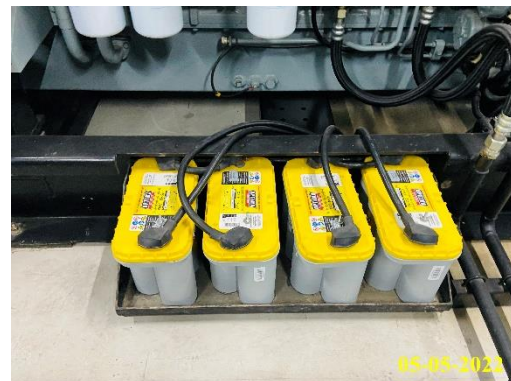
ภาพที่ 1.3.7-2 ระบบไฟฟ้าฉุกเฉิน
